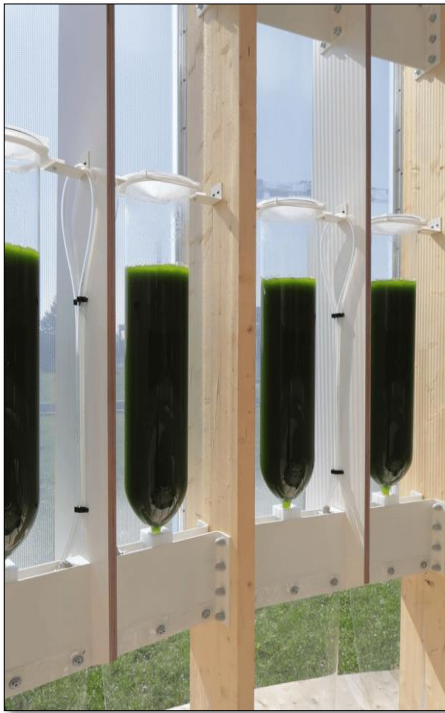
جزئیات بیوراكتورهای شیشه‌ای، سیستم پمپاژ با پا و سیستم تهویه هوا
